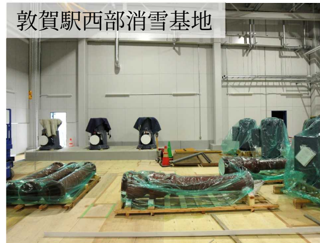
消雪基地 送水ポンプ搬入 (組立前)
