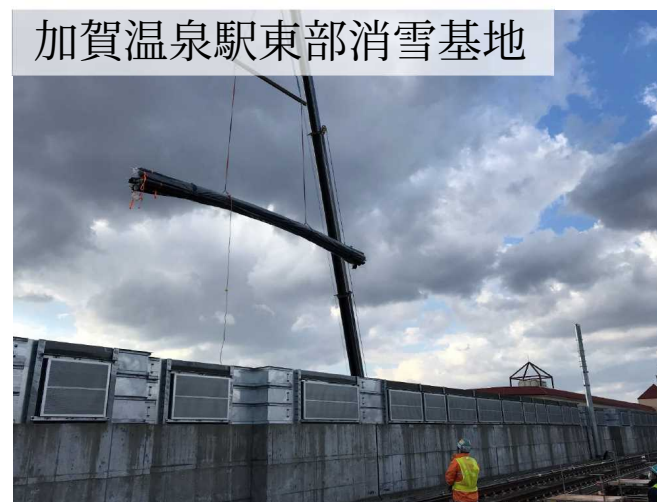
本線消雪区間 高架上配管搬入
