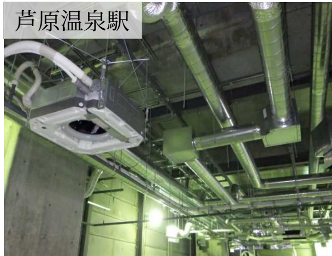
バックヤードエリア 空調設備 エアコン室内機設置
