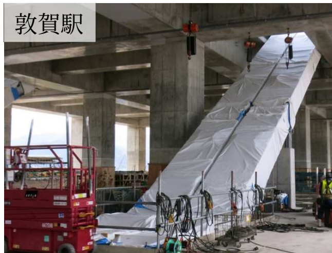
コンコース (上りホーム側) エスカレーター トラス設置
