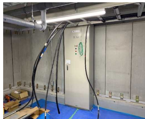
▲補助機器室 (ホーム下) の空調設備
