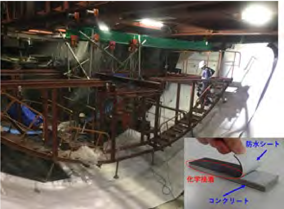
写真-1 接着性防水シート施工状況（インバート部）
