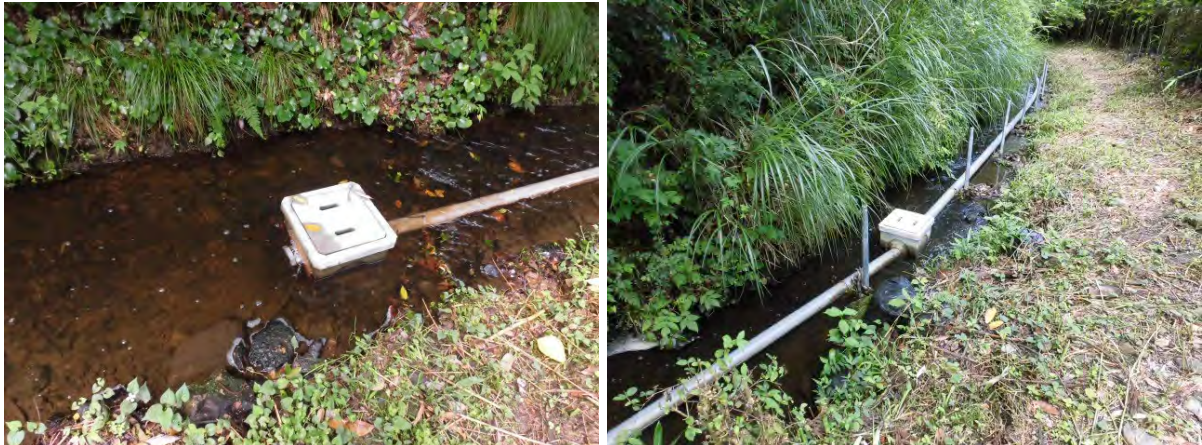
写真-1 学習田への導水路整備状況
