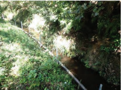
調査地の基幹水路
