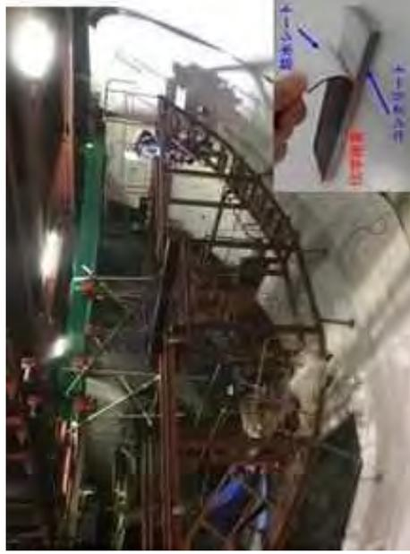
写真-1 接着性防水シート施工状況（インバート部）
