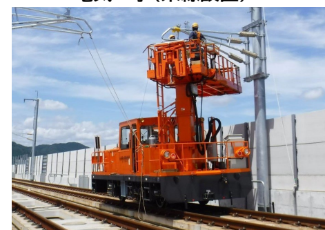
電気工事(架線設置)
