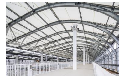
開放的なホーム空間
