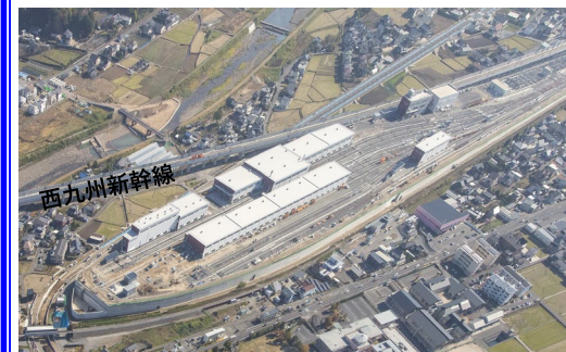
工事完成時(2022年)
