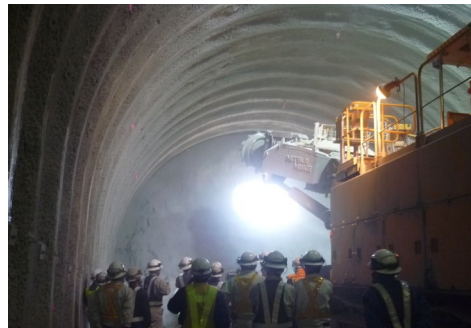
新長崎トンネルの貫通(長崎駅近傍)
