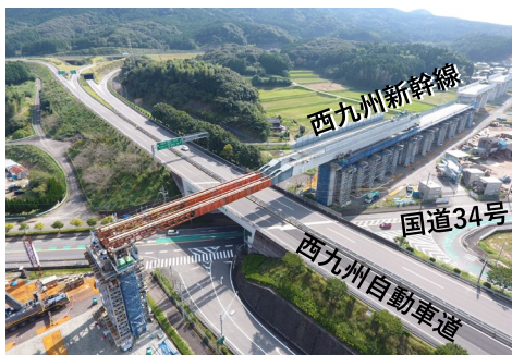
袴野架道橋の架設(武雄市内)
