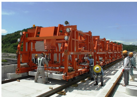
軌道工事(レール敷設)
