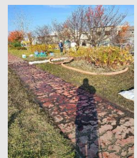
泥土等回収後の様子（地表面）
