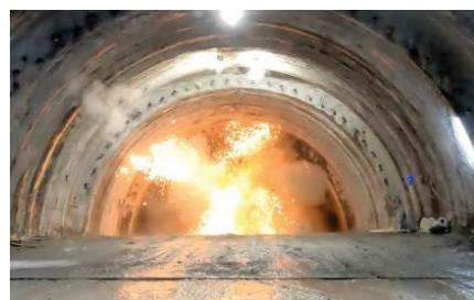
爆破で岩塊群を碎く様子。岩塊はとても硬いため、穴に詰めた破碎剤に点火し、爆発させて碎きます
