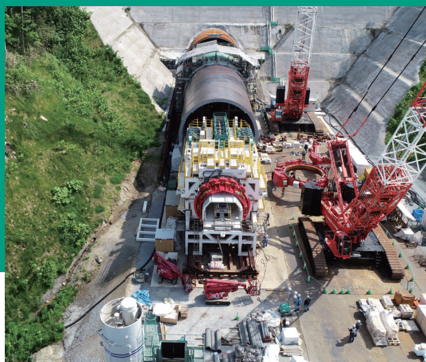
シールドマシン構築中(羊蹄トンネル有島工区)
