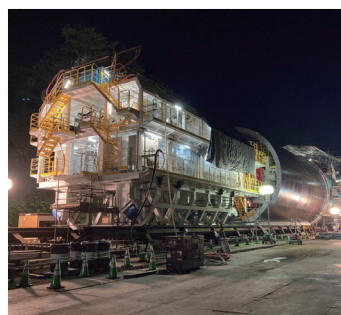
夜間も続くシールドマシンの組み上げ作業
