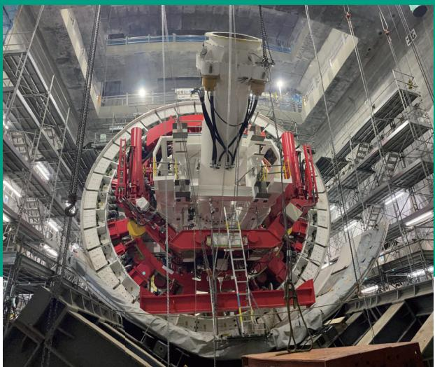
発進立坑最下部で組み上げ中のシールド機
