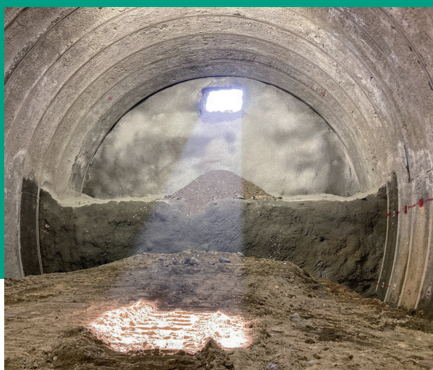
国縫トンネル貫通地点の写真。本トンネルは専用の機械で掘削を進めた。
