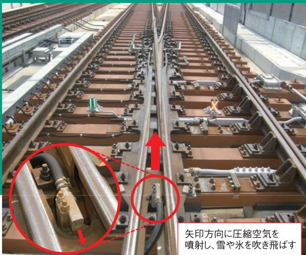
開業区間に分岐器に設置されている「エアジェット」。分岐器の不転換を防ぐ
