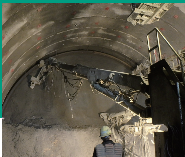
アーチ状の鋼材設置作業の一部を機械化し安全対策を強化
