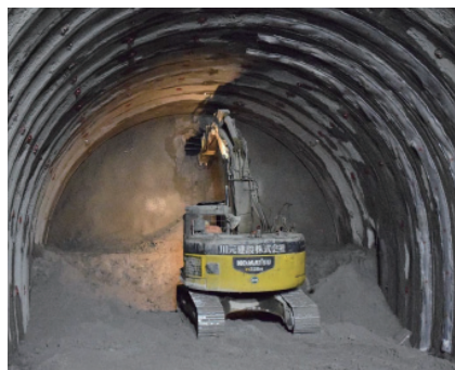
後志トンネルの落合工区が隣接工区と繋がった瞬間
