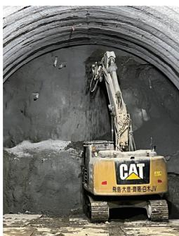
もろい地質のニセコトンネル切羽・掘削状況
