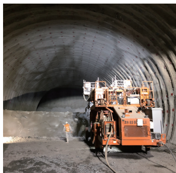
建設中の大断面トンネル（渡島トンネル）
