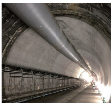
建設中の羊蹄トンネル
