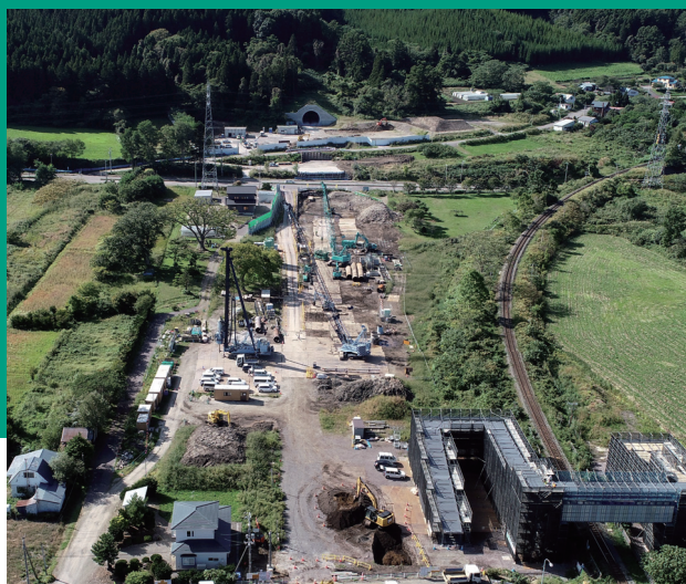
建設中の市渡高架橋。奥に見えるのは渡島トンネルの入口
