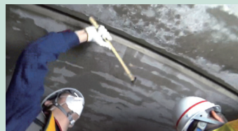
何をしているでしょう?／ニッ森トンネル(鹿子)工区
