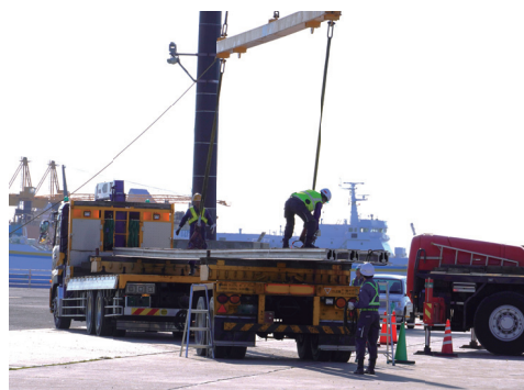
運搬船から陸揚げされたレールはポルトレラーで函館港湾内の一時仮置き場所へ
