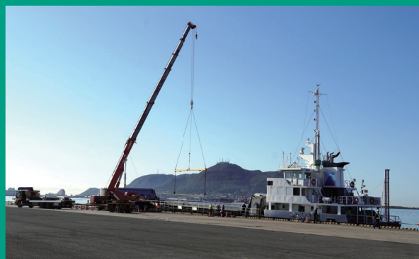
函館山を背景に、運搬船から函館港に陸揚げされるレール
