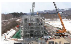
平里高架橋建設工事の様子
