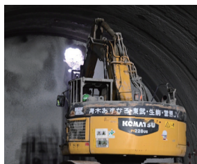
幌内トンネル貫通の様子
