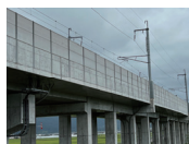
北海道新幹線(新青森・新函館北斗間)のラーメン高架橋
