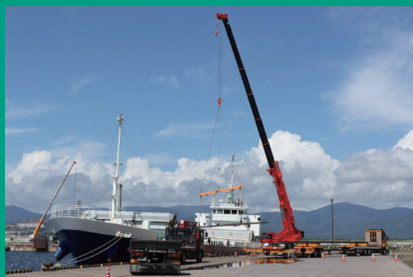
岩内港(岩内郡岩内町)に陸揚げされる様子
