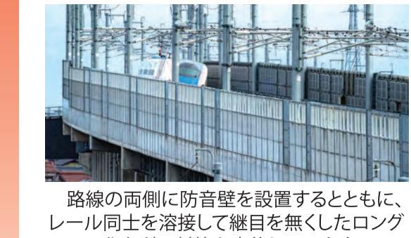
路線の両側に防音壁を設置するとともに、レール同士を接して壁面を無くしたダブルレールなどの対策を実施しています。
