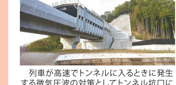
列車が高速でトンネルに入るときに発生する微気圧波の対策としてトンネル坑口に緩衝工を設置しています。
