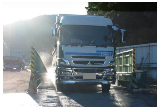
<ダンプトラックのタイヤの泥洗浄> ※道路の美観、安全の保持
