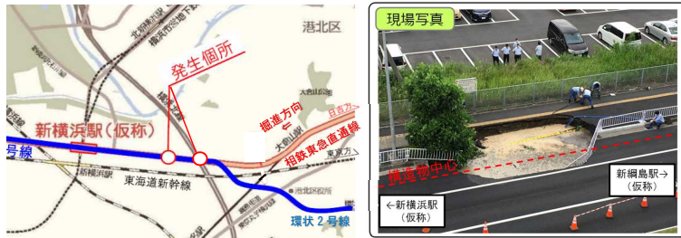
写真：令和2年6月12日発生
