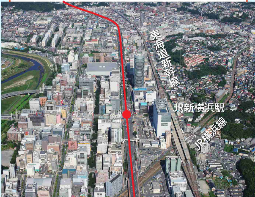
新横浜駅(仮称) 羽沢側より日吉側を望む
