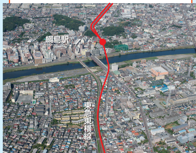
新綱島駅 羽沢側より日吉側を望む
