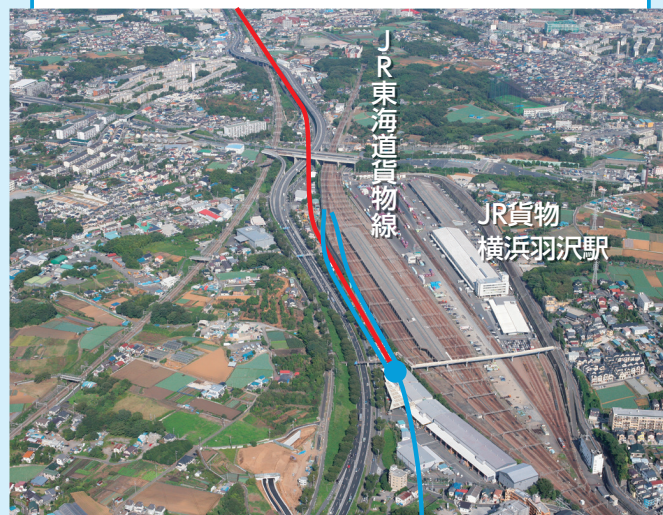
羽沢横浜国大駅 西谷側より羽沢側を望む
