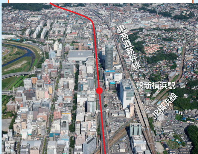
新横浜駅 羽沢側より日吉側を望む
