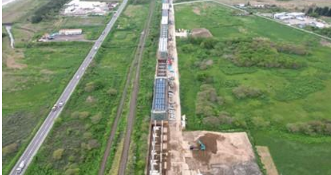
写真⑫ 平里高架橋(長万部町)
