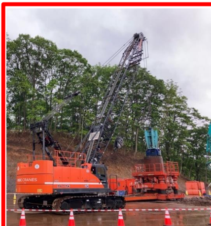
岩塊撤去状況
