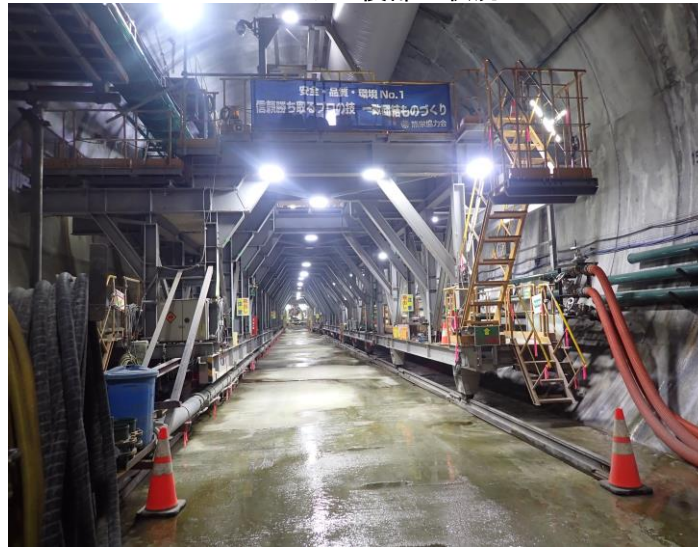
羊蹄トンネル(有島) SENSマシン後部の状況
