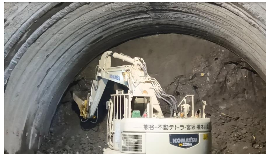
NATM掘削状況
