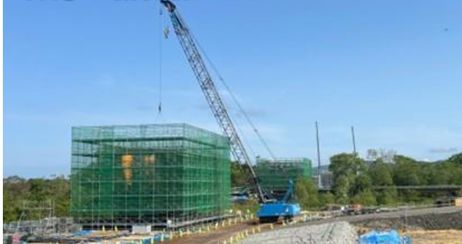
写真⑮ 大新高架橋(八雲町)
