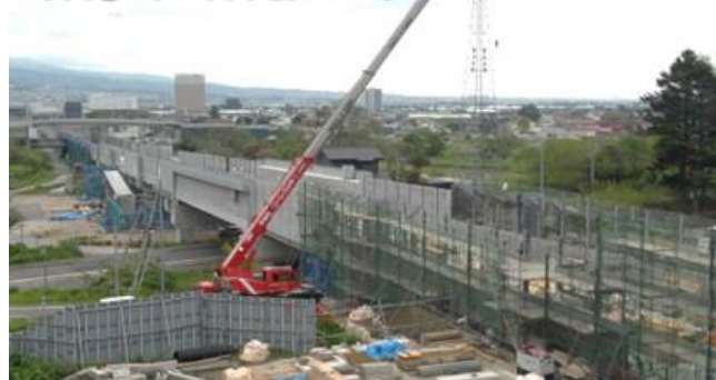
写真⑯ 市渡高架橋(北斗市)
