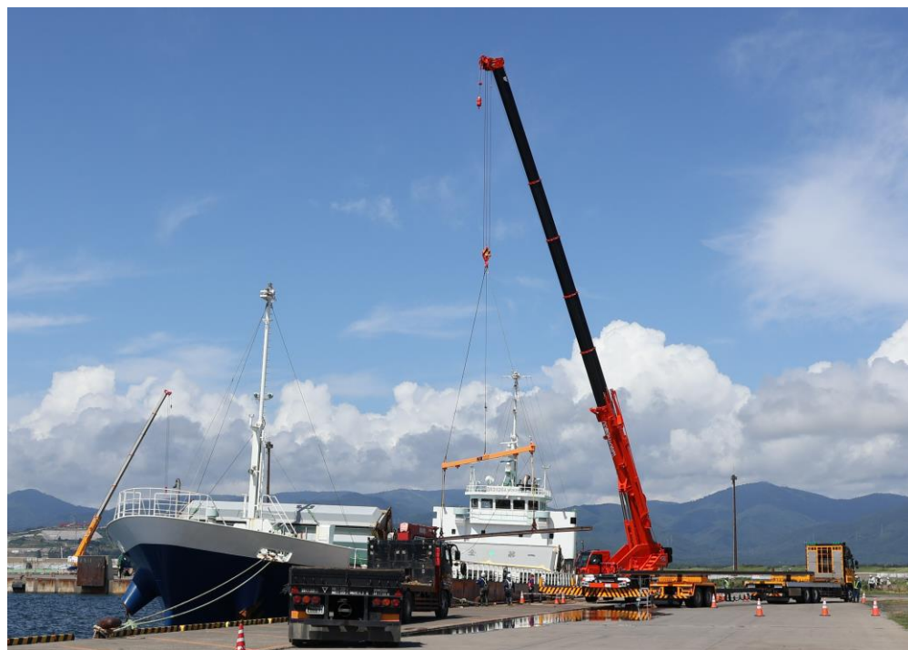
レール陸揚げの様子
