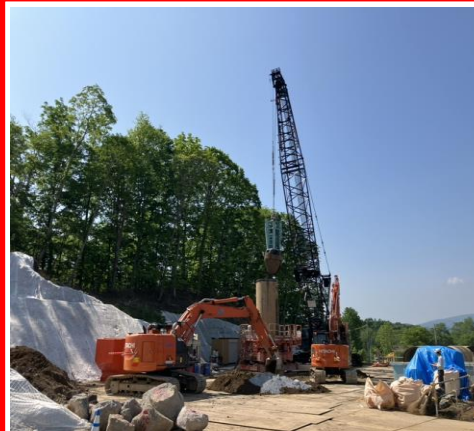
岩塊撤去状況
