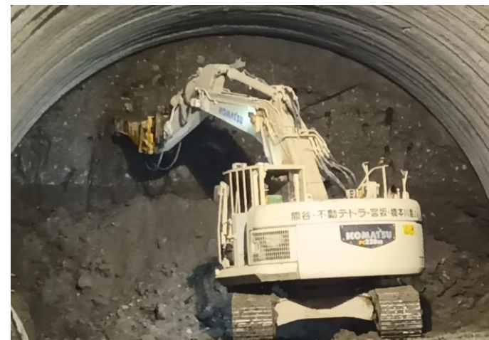
NATM掘削状況
