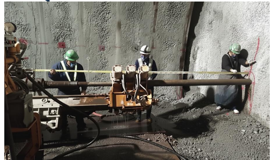
水平ボーリング実施状況
