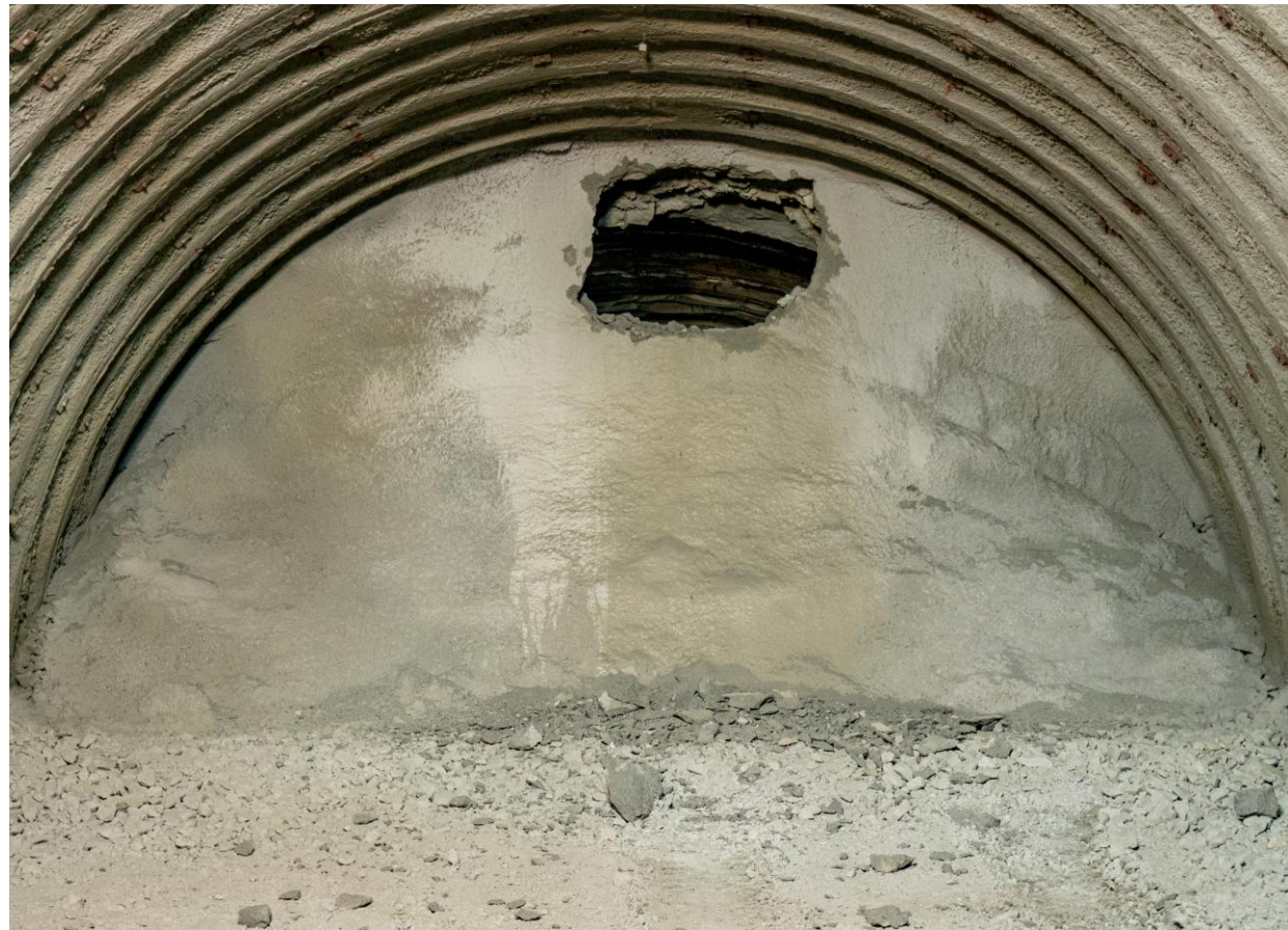
掘削完了地点の状況
