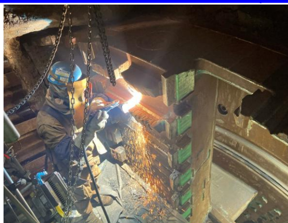
ビット交換状況
