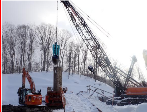
岩塊撤去状況
