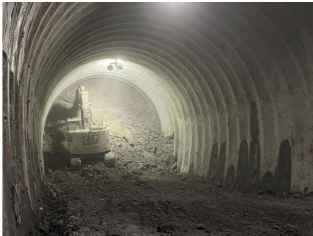
渡島トンネル(南鶴) トンネル掘削工施工状況 (新函館北斗方を望む)
