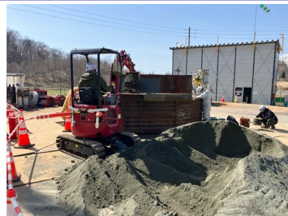
中間立坑埋戻し作業
