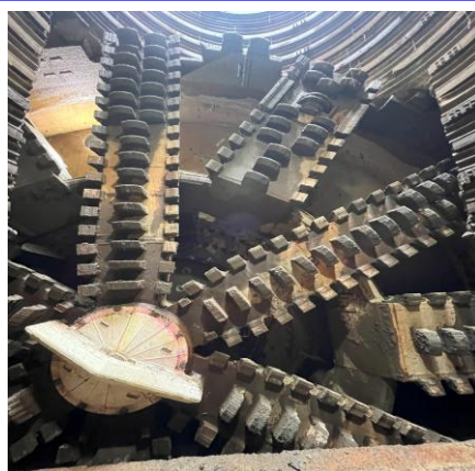
ビット交換作業完了
