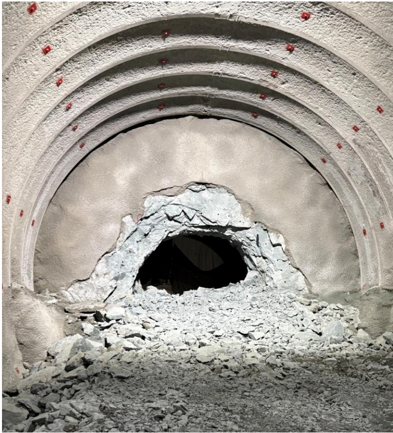
掘削完了地点の状況
