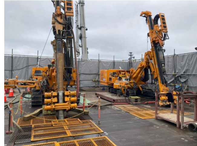
凍結管埋設の様子
