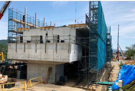
高架橋工事状況
