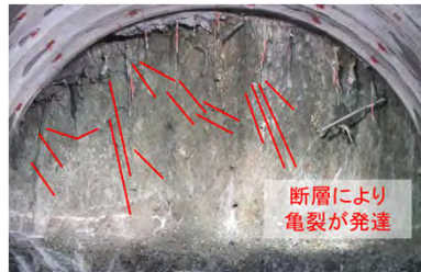
【特徴1】断層運動に伴う弱部の形成
