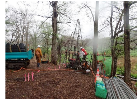
ボーリング調査状況
