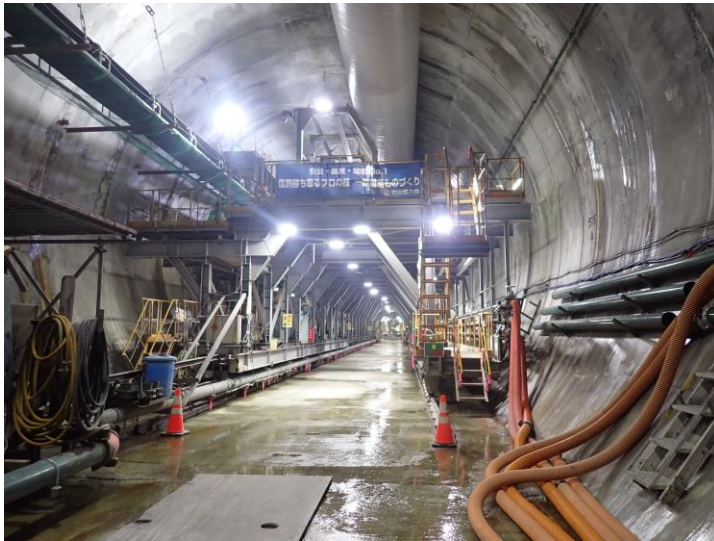
羊蹄トンネル(有島) 坑内状況
