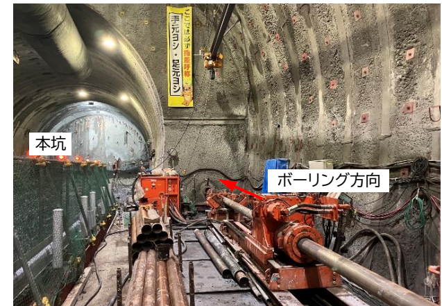
台場山工区ボーリング削孔状況
