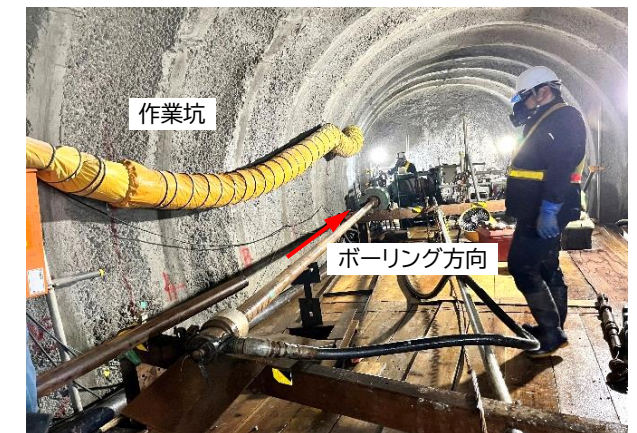
南鶉工区ボーリング削孔状況
