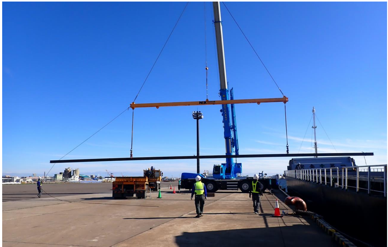
レール陸揚げ状況
