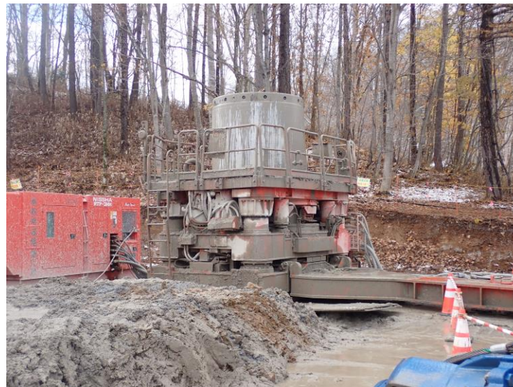
羊蹄トンネル(有島) マシン停止位置付近地上部岩塊撤去状況
