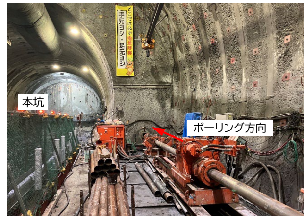
台場山工区ボーリング削孔状況
