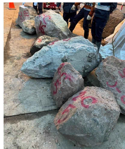
今回撤去した岩塊(長径最大約1.4m)
