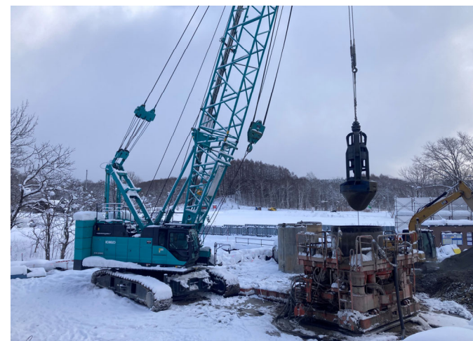
岩塊撤去状況
