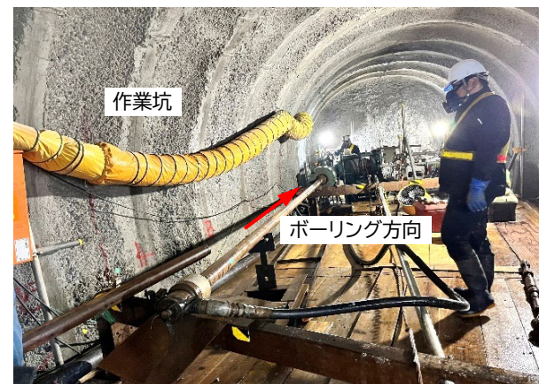
南鶉工区ボーリング削孔状況
