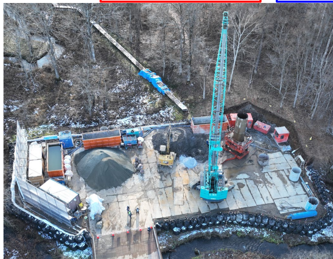
岩塊撤去状況
