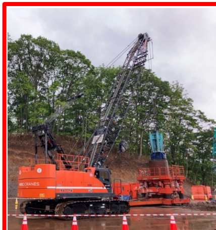
岩塊撤去状況
