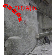
吹付けコンクリートのひび割れ
