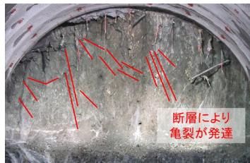
【特徴1】断層運動に伴う弱部の形成
