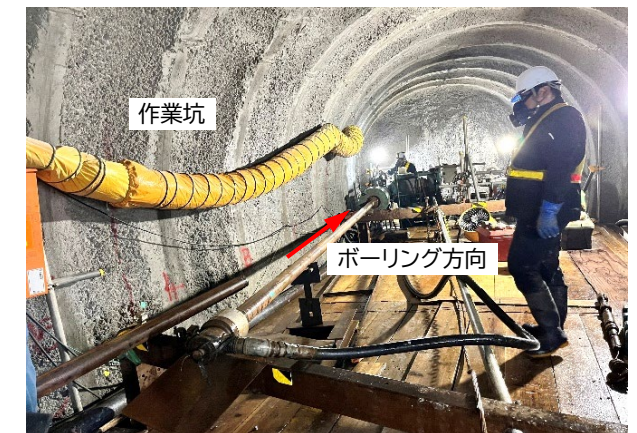
南鶉工区ボーリング削孔状況
