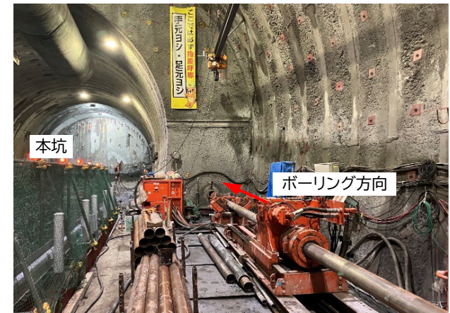
台場山工区ボーリング削孔状況
