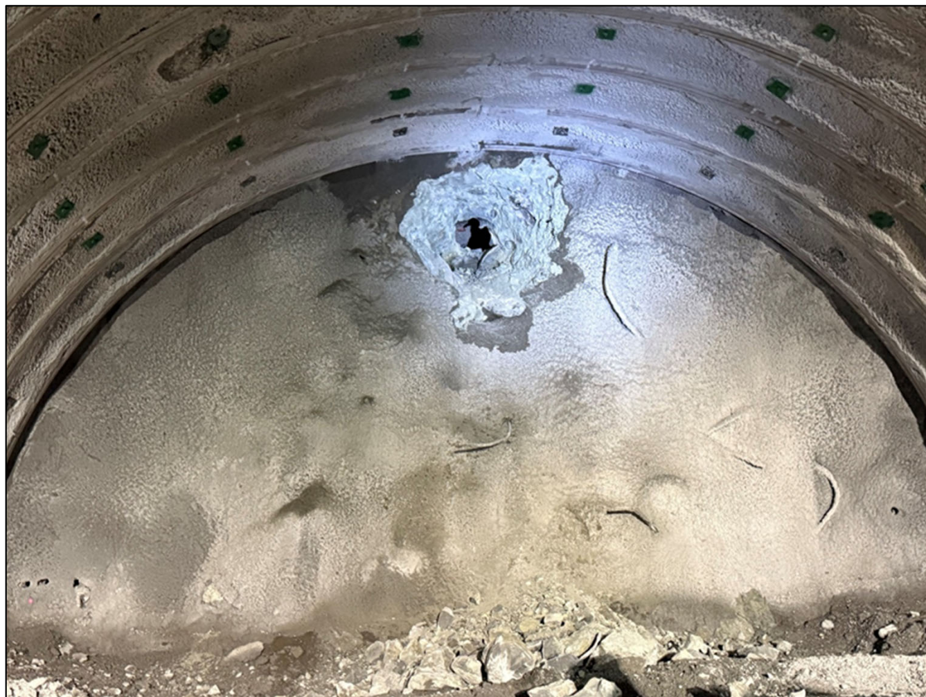
掘削完了地点の状況
