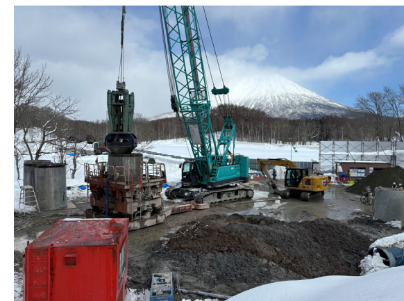
岩塊撤去状況
