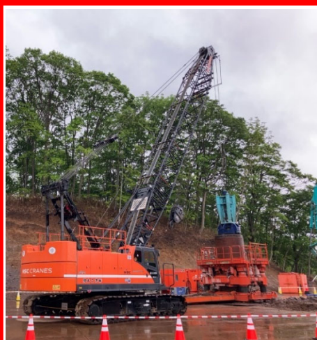
岩塊撤去状況
