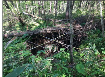
地表面陥没状況
