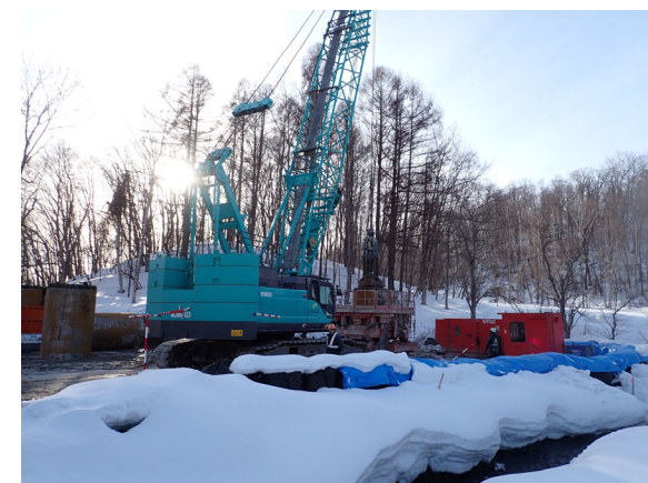
岩塊撤去状況
