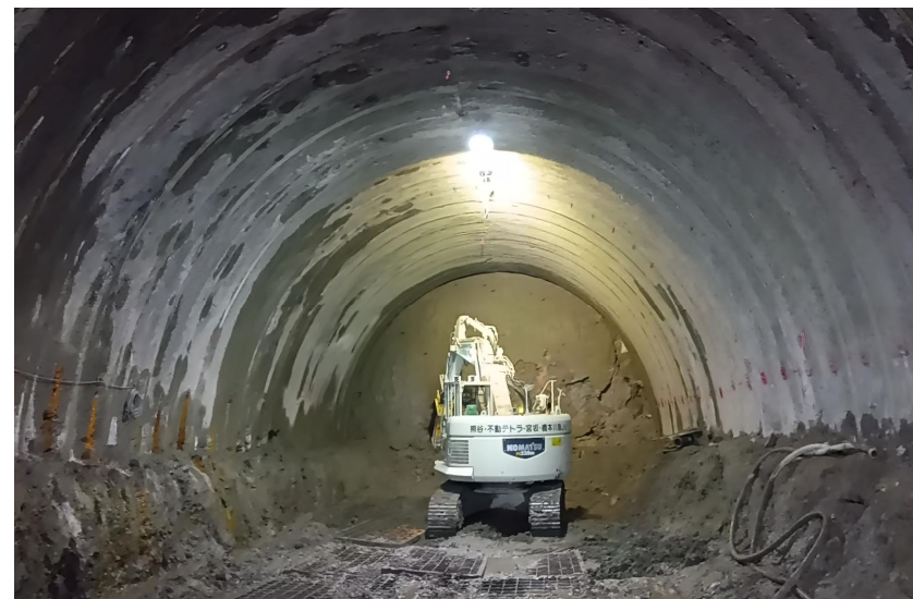
NATM掘削状況
