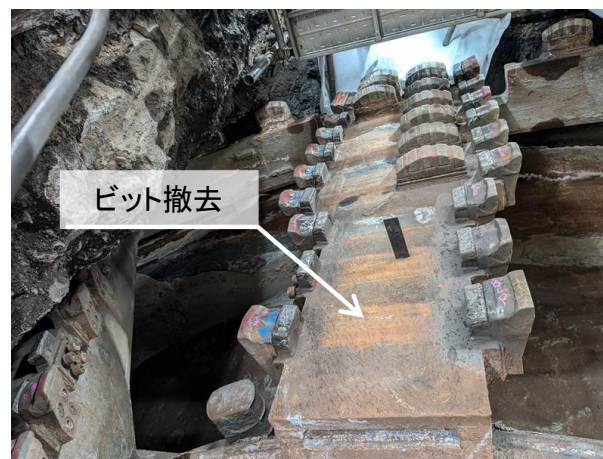
摩耗ビット撤去
