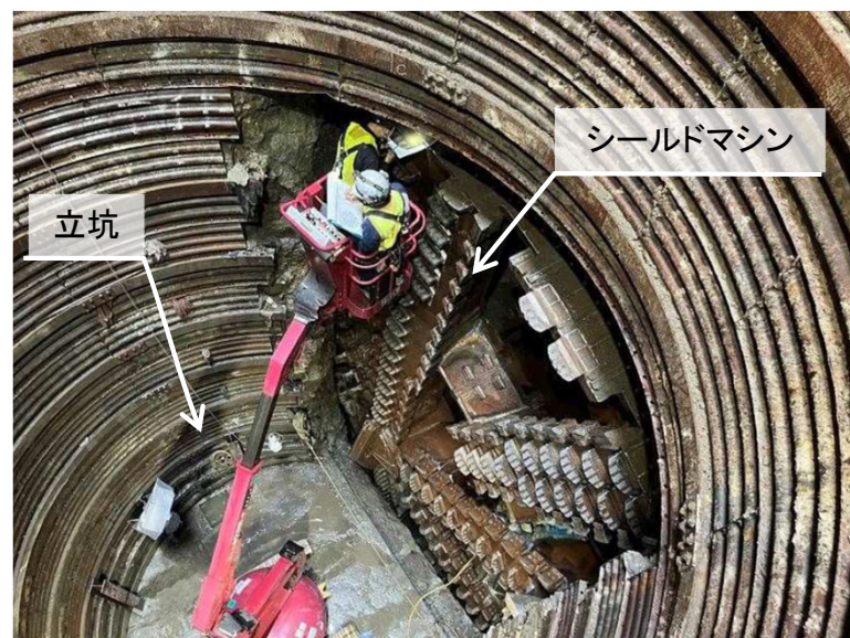
シールドマシンビット点検状況
