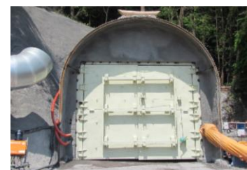
トンネル坑口に 防音扉の設置
