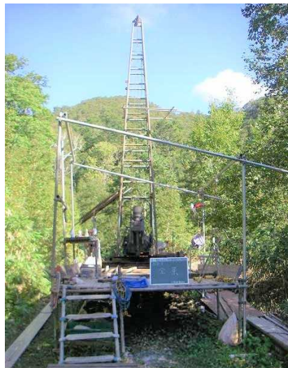
【ボーリング調査(イメージ)】
