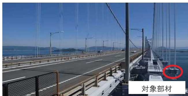
〔ケーブル補修〕
