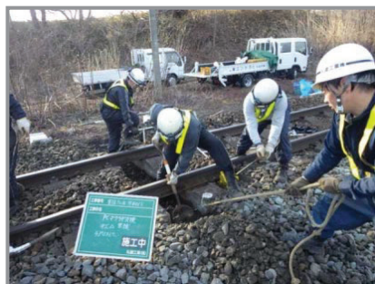
線路の検査・修繕 (黄線区)
