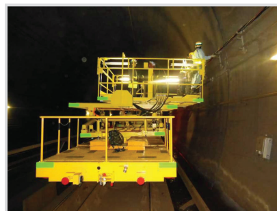
高圧ケーブルの修繕 (青函トンネル)
