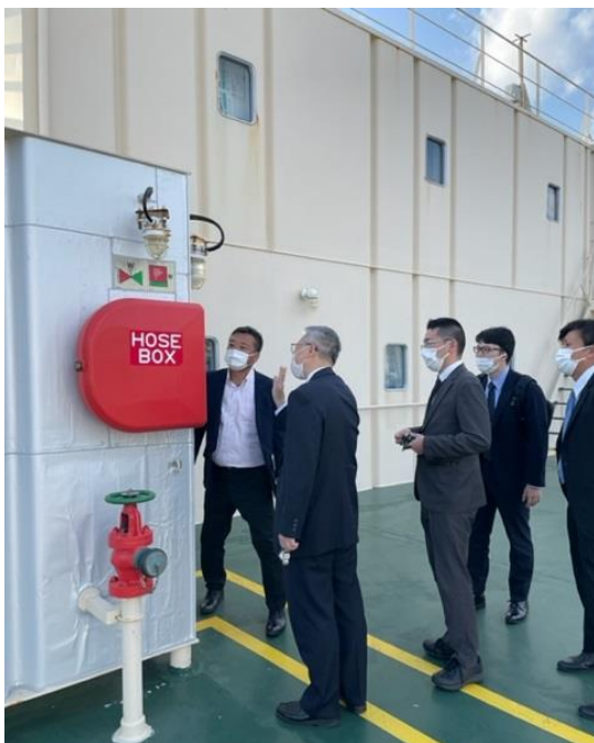
施工箇所にて大澤取締役の説明を受ける機構職員。夏場は40度以上になるそうです
