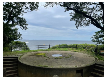
異国船の江戸湾進入を防ぐために建設された砲台跡
