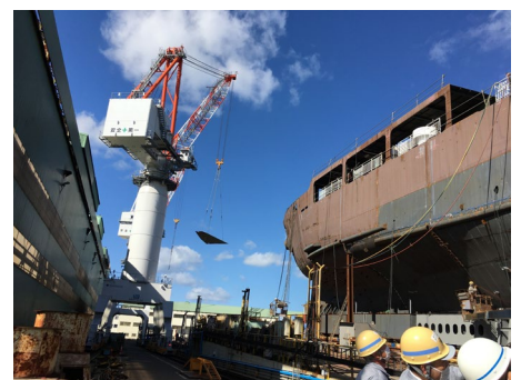
150トン型のジブクレーン
