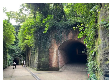
地下施設は弾薬庫として利用
