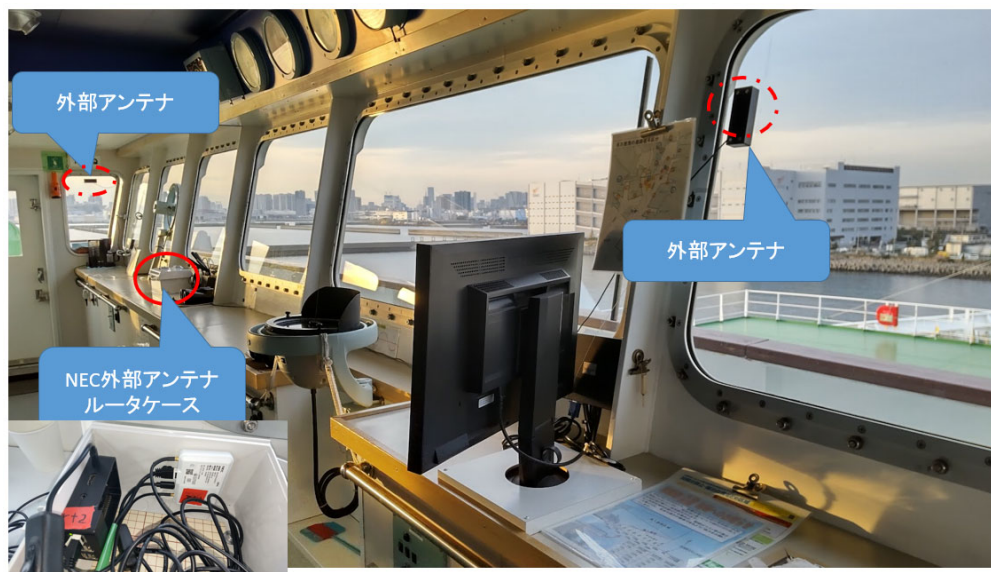
操舵室設置状況
