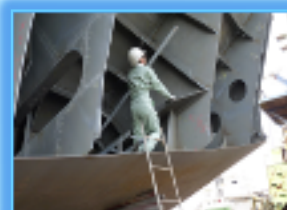
建造中の工事監督の様子
