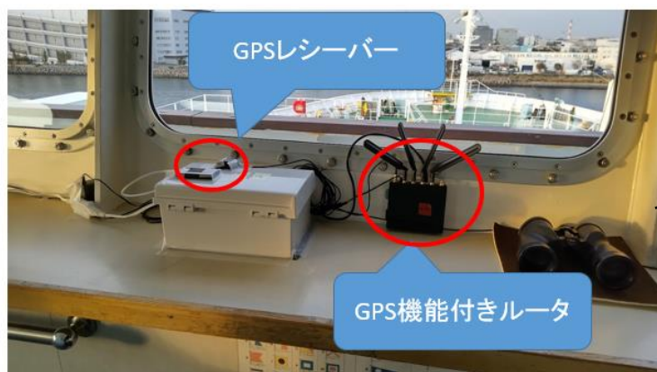
ブリッジへ設置
