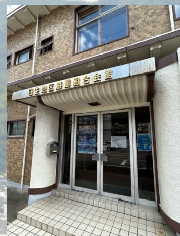
日生地区海運組合外観
